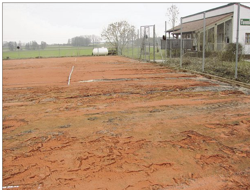
Komplett zerstört wurden durch das Hochwasser alle Tennisplätze. – Der gesamte Belag muss abgetragen werden. (Foto: Ertl)
